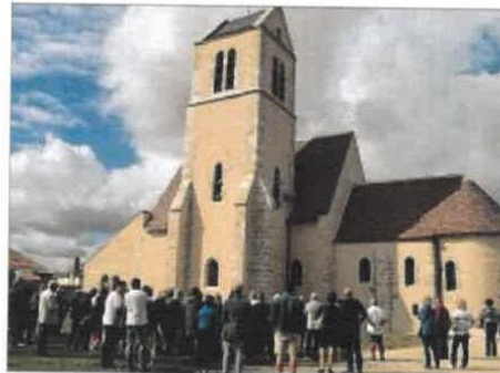
Le village a célébré la restauration extérieure de l'église en espérant que le chantier se poursuive bientôt à l'intérieur.
