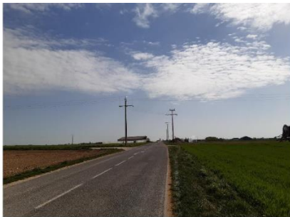
Vue avant travaux
