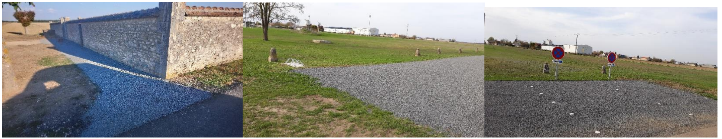
Les travaux du parking du cimetière sont terminés
