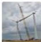
Enfin, la dernière phase de chantier consistera à monter les éoliennes à l'aide de grues de levage, en assemblant les différentes sections de tours, puis en levant la nacelle et les 3 pâles.
