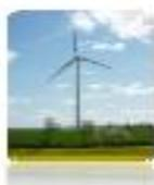
D'une puissance cumulée de 24 MW, les nacelles des 12 éoliennes culmineront à 80 mètres. Chacune des 3 pâles mesurera 45 mètres. Le poids total de l'éolienne sera de 230 tonnes.
